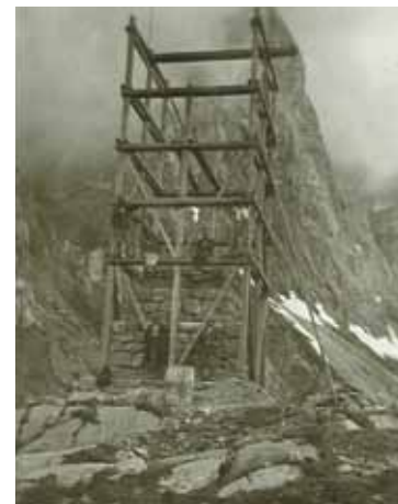
Bau des Denkmals am Frauenhügel
