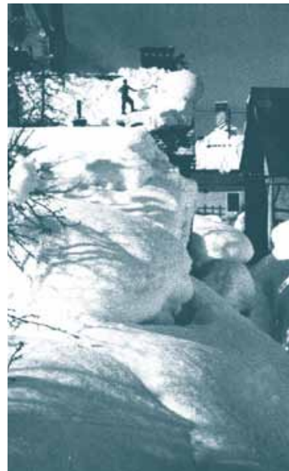
1951 mussten die Dächer mehrmals abgeschaufelt werden.
