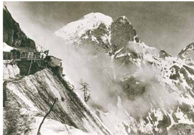
Unterstände mit Seilbahnstation; Kleiner Pal 1916
